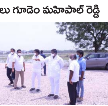
పటాన్ చేరు, ఏప్రిల్ 28, 2021 (ప్రజాపాలన ప్రతినిధి) : సుమారు 20 కోట్ల రూపాయల అంచనా వ్యయంతో పటాన్ చేరు పట్టణంలోని సాకి చెరువు వద్ద చేపడుతున్న సుందరీకరణ పనులను స్థానిక శాసనసభ్యులు గూడెం మహిపాల్ రెడ్డి బుధవారం పరిశీలించారు.
